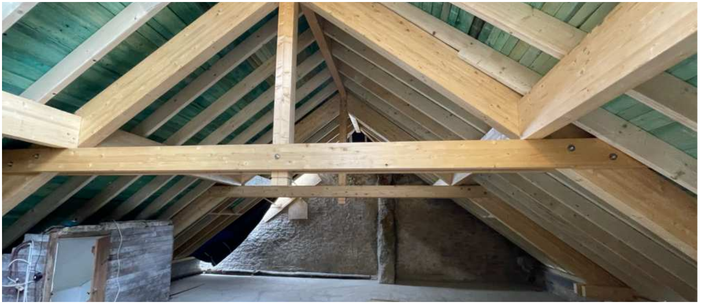
Dachstuhl und Holzkonstruktionen
