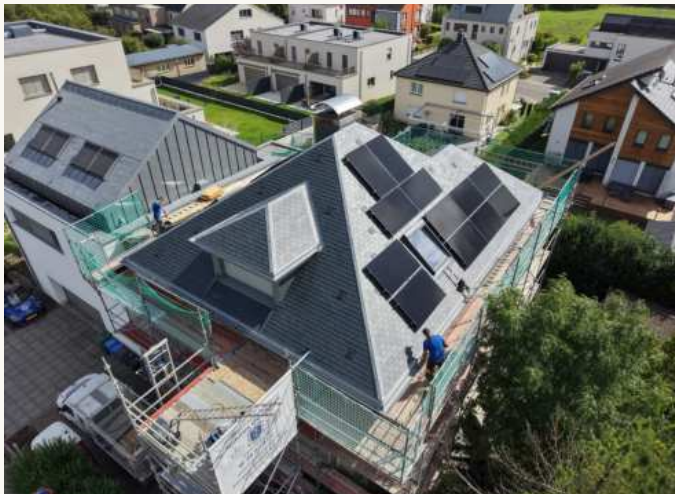
Dach- und Klempnerarbeiten
